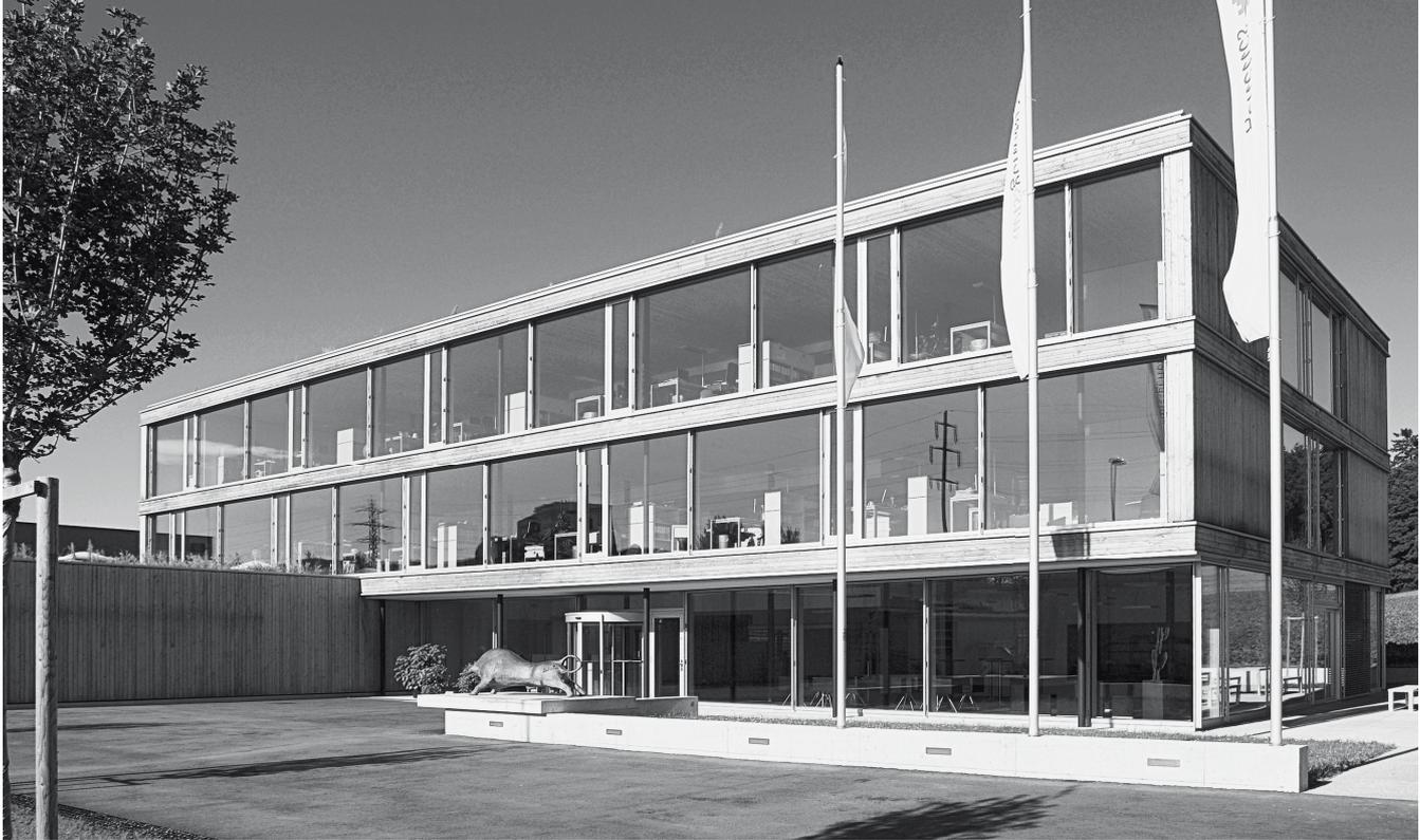
Konstruktiv handelt es sich beim Hauptgebäude um einen dreifeldrigen Skelettbau. Die Brettstapel der Holz-Beton-Verbunddecken tragen ihre Lasten, eingeschoben in liegende H-Profile aus Stahl, über Stahlstützen oder, wo möglich, über die Erschließungskerne ins Untergeschoss ab. Auf der Decke aufgebaut nimmt ein Hohlboden die Leitungen der Gebäudetechnik auf.
